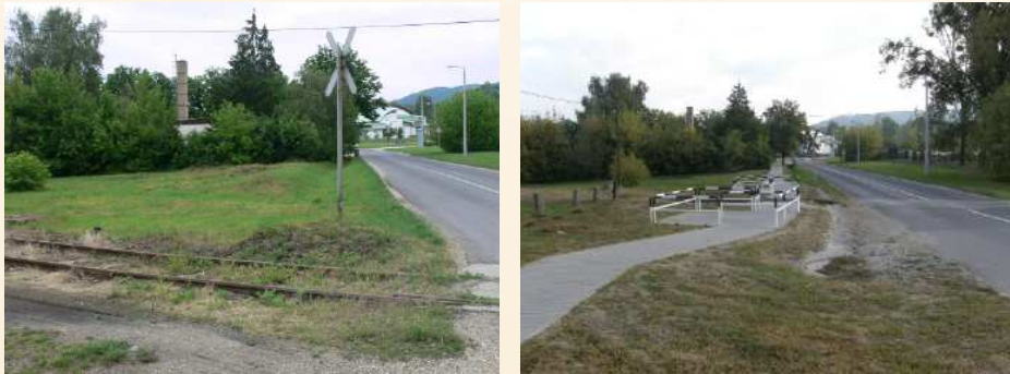
Járdaépítés a mentőállomás mellett
