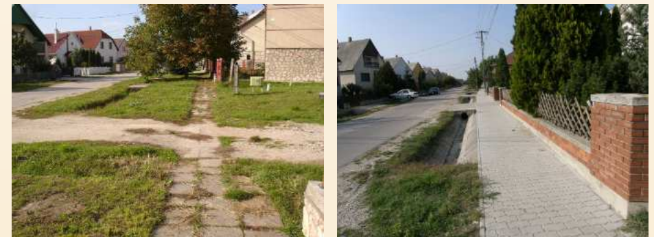
Járdaépítés az Orgona utcában
