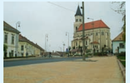
Szt. István téri parkoló és járda felújítása
