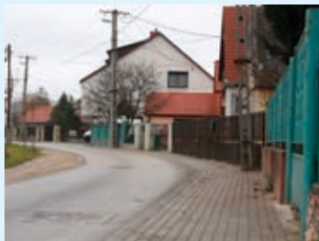
Kút ér melletti járdaépítés a Dózsa és Kodály utcák között
