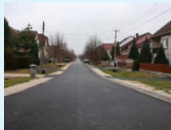
Mátyás király utcai burkolat felújítása
