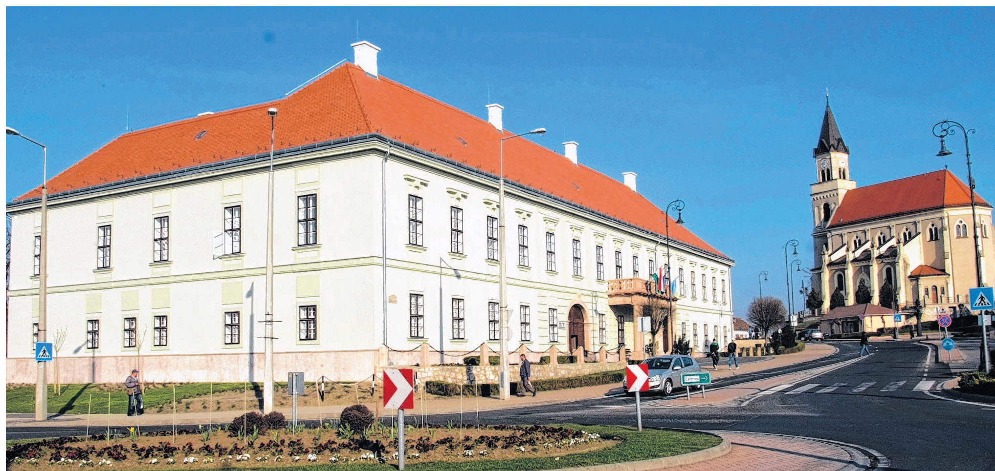
Ismét régi szépségében pompázik a polgármesteri hivatal kastélyépülete. Nem csak a tetőt és a homlokzatot újították föl, de korszerűsítették a fűtésrendszert, és javították a nyílászárókat is
